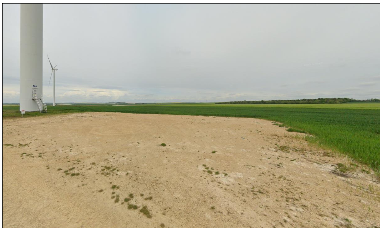
Figure 9 – Photographie de la plateforme d'une éolienne, entretenue selon la réglementation en vigueur.
